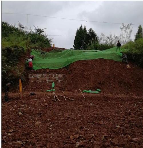
施工作业带彩条布覆盖过程
